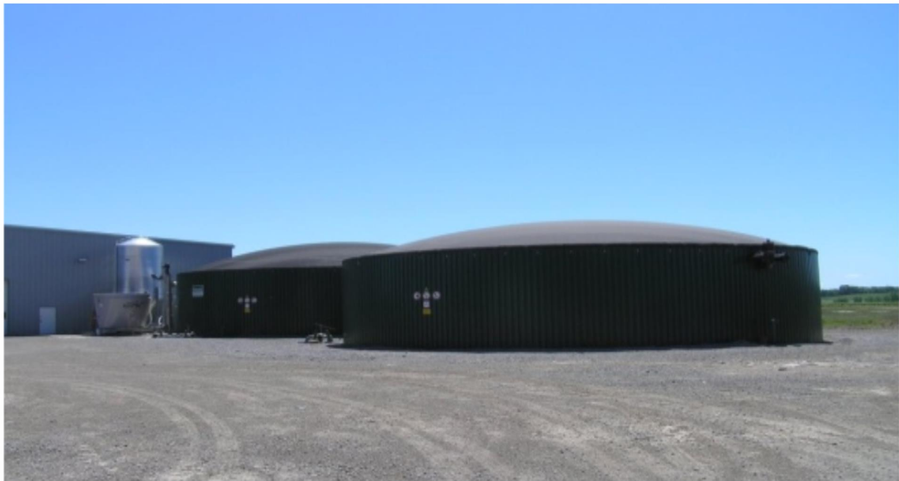
Biogazownia rolnicza w pobliżu oczyszczalni ścieków o mocy 370 kW
